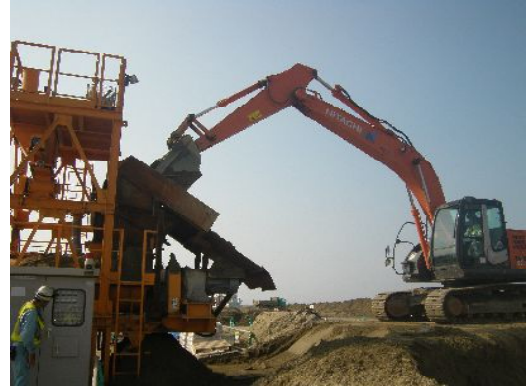
原泥土投入(バックホウ)
