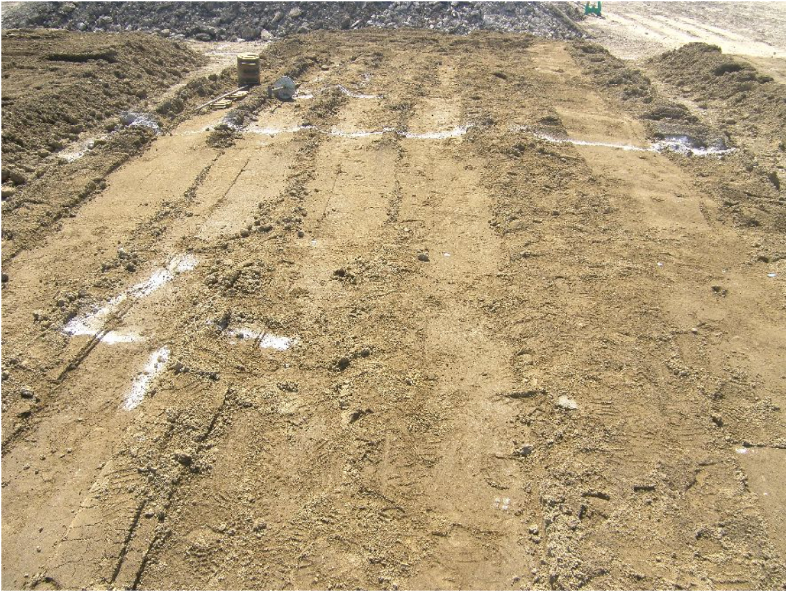
敷き盛り土として使用
