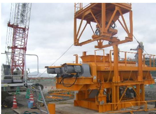
粉体供給機設置
