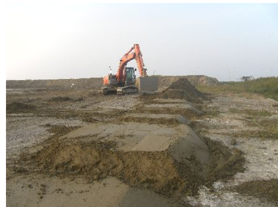
改良処理土仮置き
