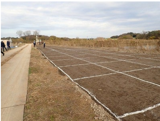
写真1 改良前の状況
