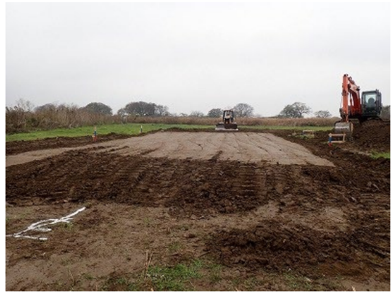
写真6 2層目転圧後の状況
