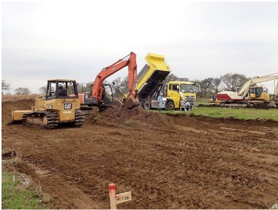
写真5 まき出し、転圧の状況
